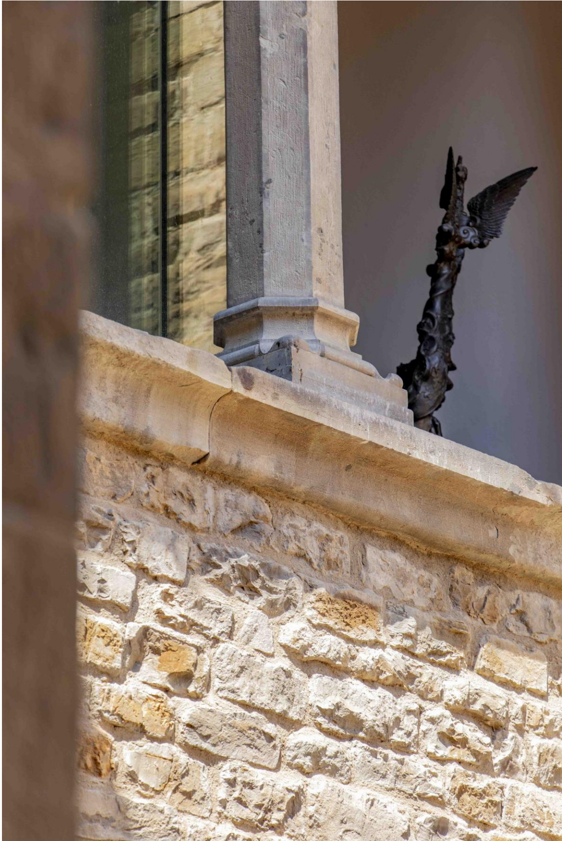
Scorcio della vista sul cortile interno e sulla loggia del terzo piano con la scultura Paradiso e Inferno di Greg Wyatt vista dal secondo piano. Fotografia Corinna Del Bianco.
