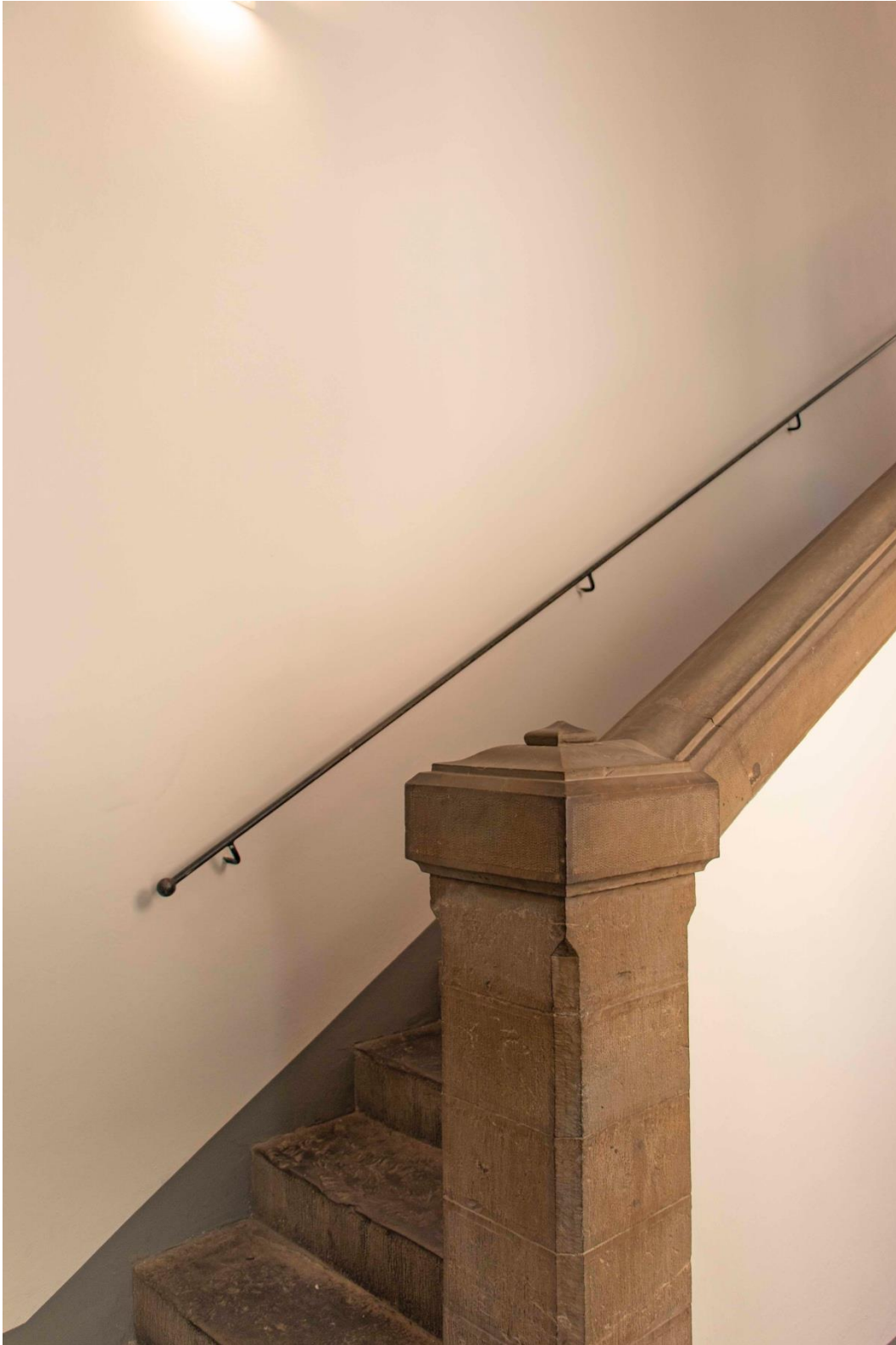
Dettaglio della scala che distribuisce i piani del museo rifinita nella tradizionale pietra serena. Fotografia Corinna Del Bianco.
