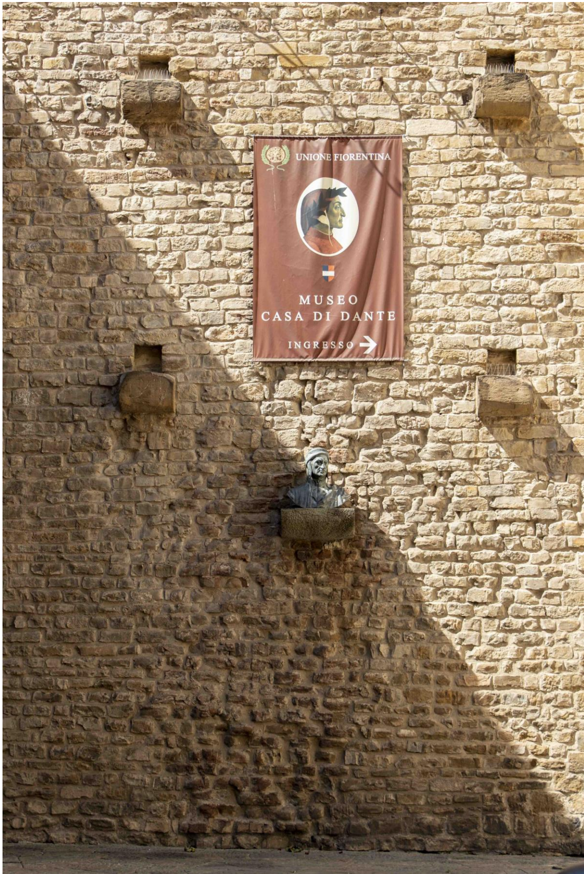
Vista del prospetto della torre rivestito in pietra forte, con le buche pontarie, il busto in bronzo di Dante e l'indicazione dell'ingresso sul lato della torre. Fotografia scattata dalla piazzetta di Via Santa Margherita. Fotografia Corinna Del Bianco.
