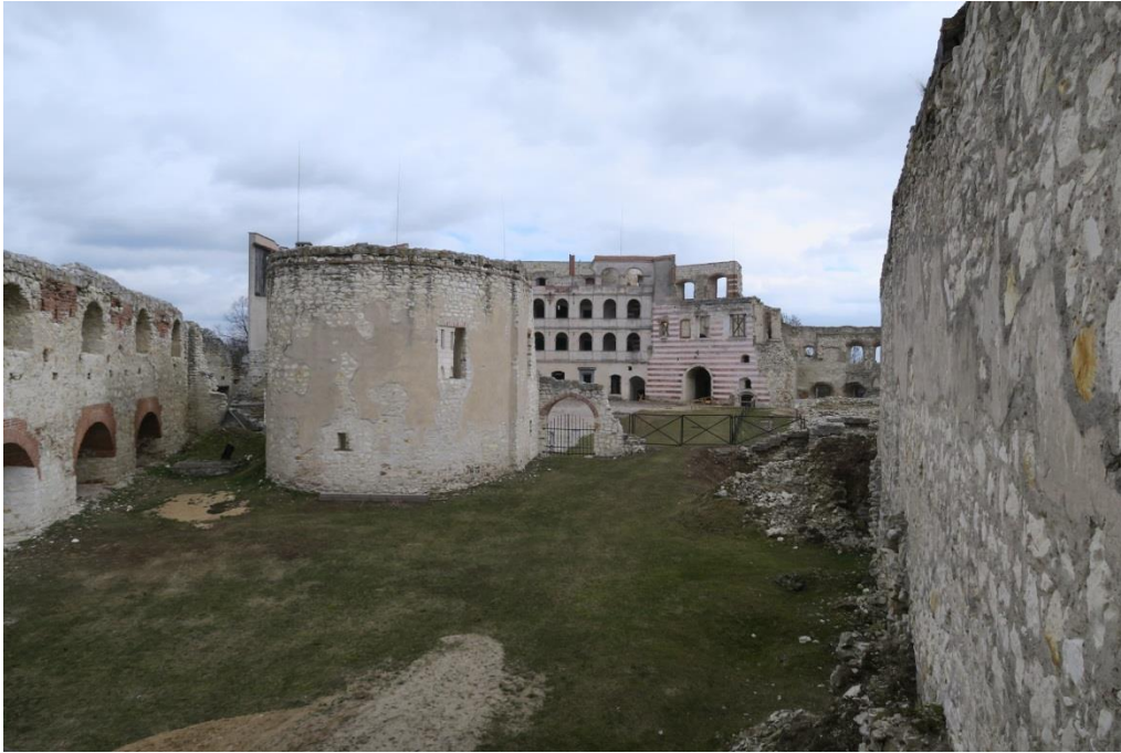
Castello di Janowiec. Veduta della cappella e dell'ala est. Foto di A. Fortuna-Marek.
