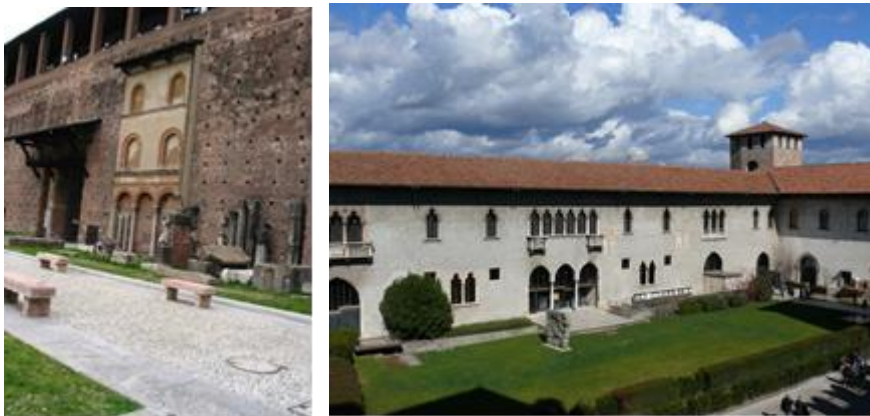
Da sinistra verso destra: Castello Sforzesco, Milano, Italia (Foto di Nora Lombardini); Castelvecchio, Verona, Italia (Foto di Marta Rota).
