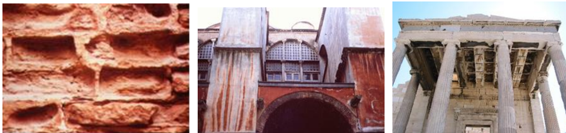
Da sinistra verso destra: erosione; scolorimento; crosta nera (Foto di Nora Lombardini).
