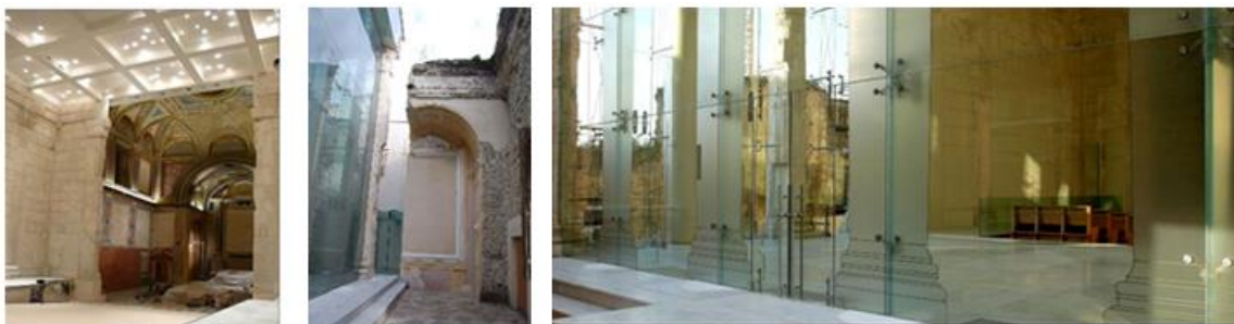
Pozzuoli (NA), Italy, Progetto di conservazione del Tempio Duomo Rione Terra, 2003-2014. By prof. Arch. M Dezzi Bardeschi.
