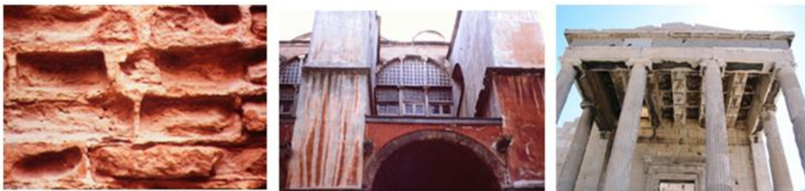
Da esquerda para a direita; Erusão; Descoloração; Crosta preta. fotos de Nora Lombardini
