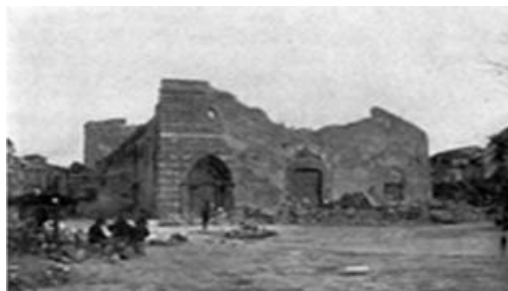
S Boscarino, A Catedral de Messina após o terramoto de 1908: da consolidação das estruturas sobreviventes à reconstrução total, Ensaios em homenagem a Guglielmo de Angelis d'Óssat, Roma, 1987, p.523
