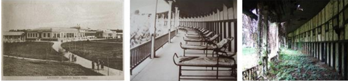
Legnano, Estúdio de Restauração - Politécnico de Milão. Projeto de levantamento e conservação do “Sanatório Regina Elena”, 1924. Alunos: L. Bianchini, V. Bruno, A. Tettamanti, E. Volontè
