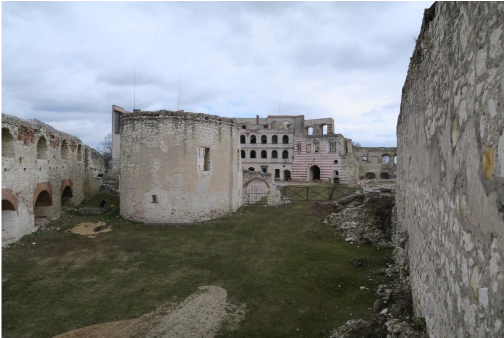
Zamek w Janowcu. Widok na kaplicę i skrzydło wschodnie. Fot. A. Fortuna-Marek
