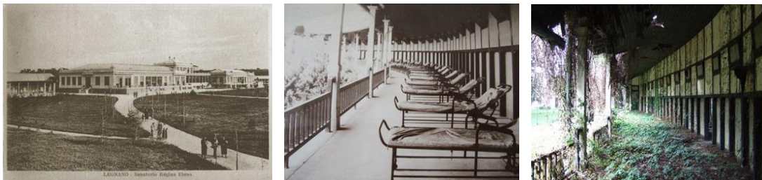
Legnano, Restoration Studio - Politecnico di Milano. Survey and conservation project of the “Regina Elena Sanatorium”, 1924. Students: L. Bianchini, V. Bruno, A. Tettamanti, E. Volontè
