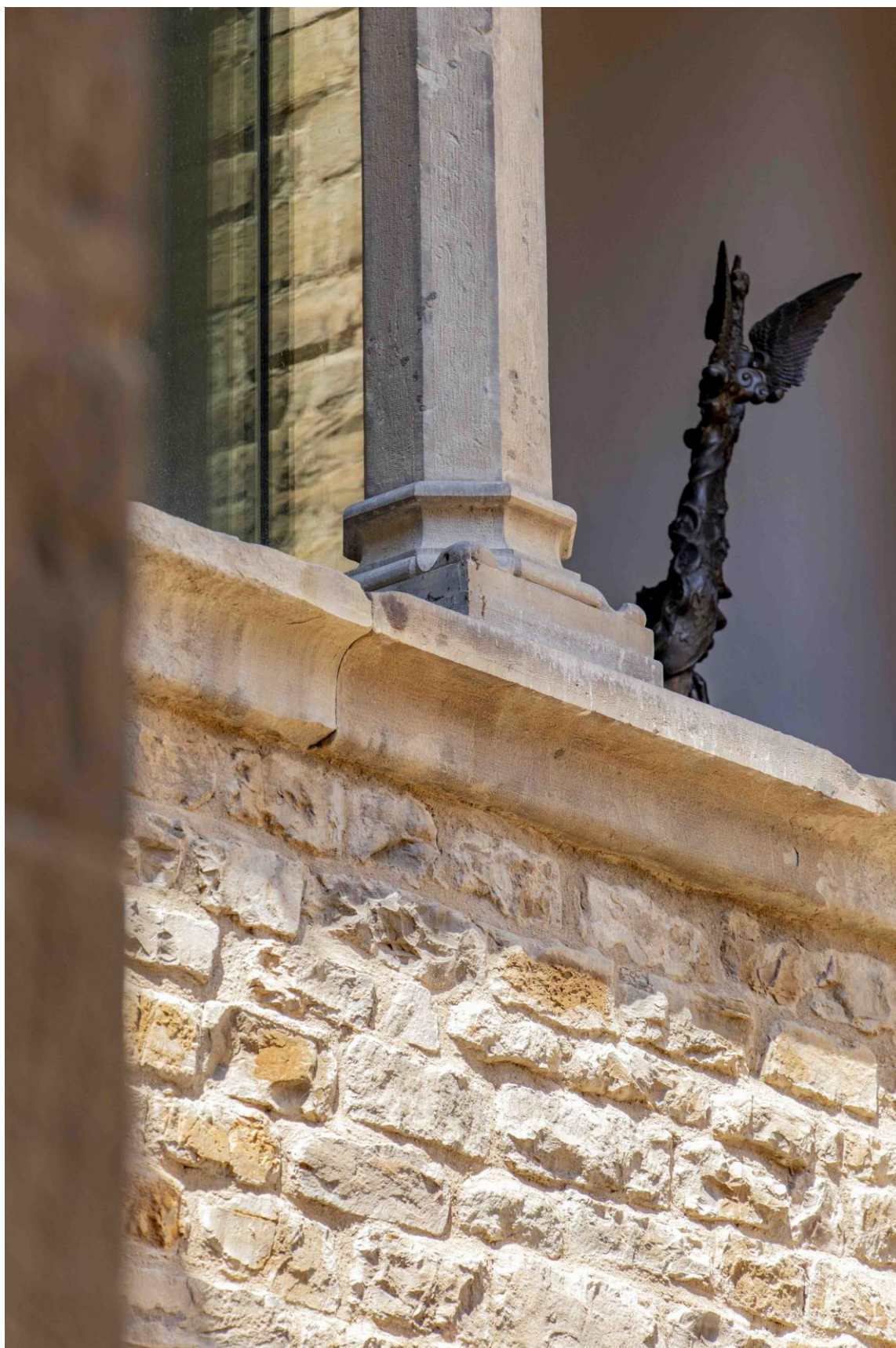
Figura 9: Vista parcial do pátio interno e galeria no terceiro andar com a escultura Paradise and Hell de Greg Wyatt, vista do segundo andar. Fotografia de Corinna del Bianco.
