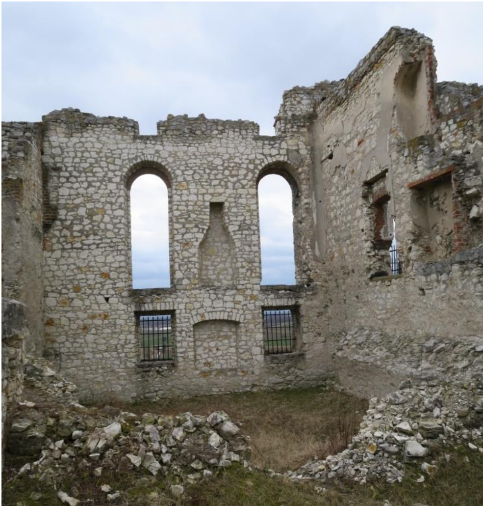
Destrução da substância histórica. Foto de A. Fortuna-Marek
