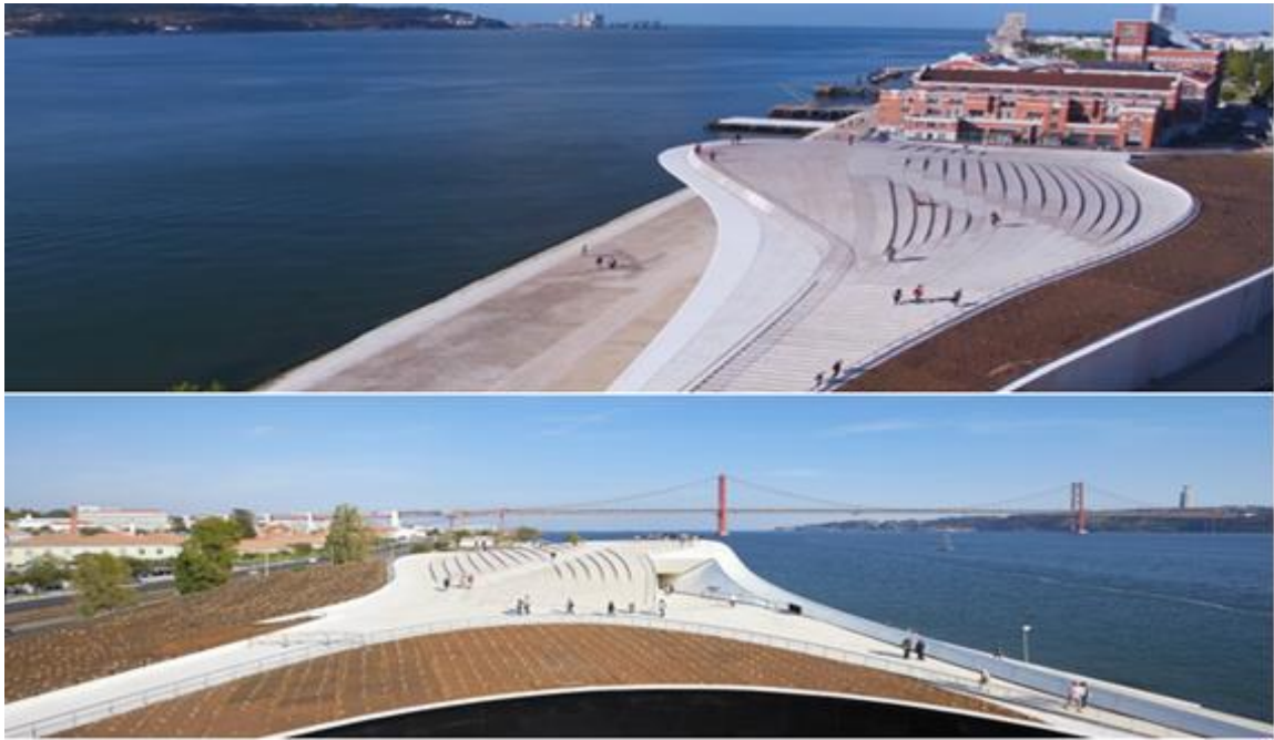
Figura 10- Vista Este e Oeste da cobertura/terraço e caminhos (net b, 2021)
