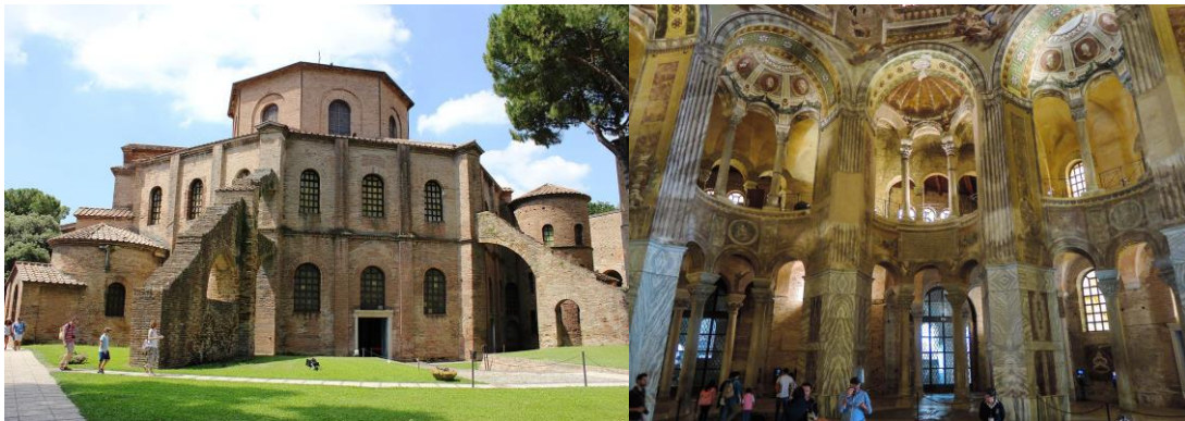
San Vitale - veduta dell'esterno
